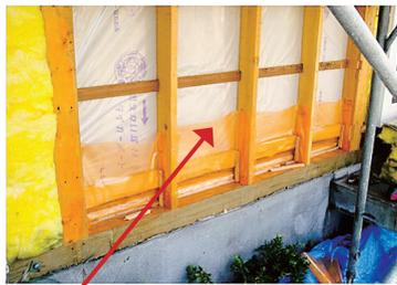
補強ポリフィルムを隙間なく気密に張る
