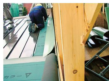
**アドバイス** ▶ 屋根は落雪屋根と無落雪屋根に大別されます。仕上材料が金属板でも、横葺きや蟻掛け等の葺き方があります。雨水の侵入を防ぐ防水下地となるアスファルトルーフィング(黒いシート状のもの)や、小屋裏結露を防ぐ小屋裏換気口を確認しましょう。
